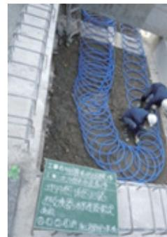
地中熱交換回路の水平埋設工事
