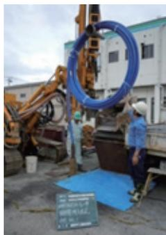
地中熱交換回路の垂直埋設工事
